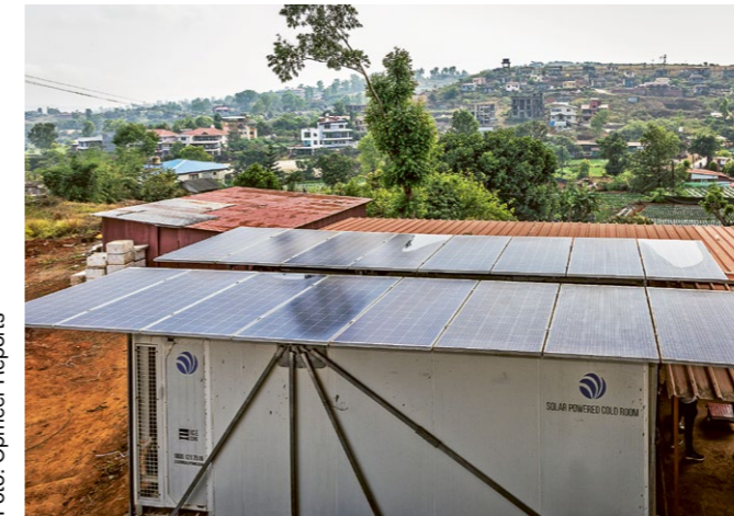
Solarbetriebener Kühlraum in der Nähe von Pune, Indien.
